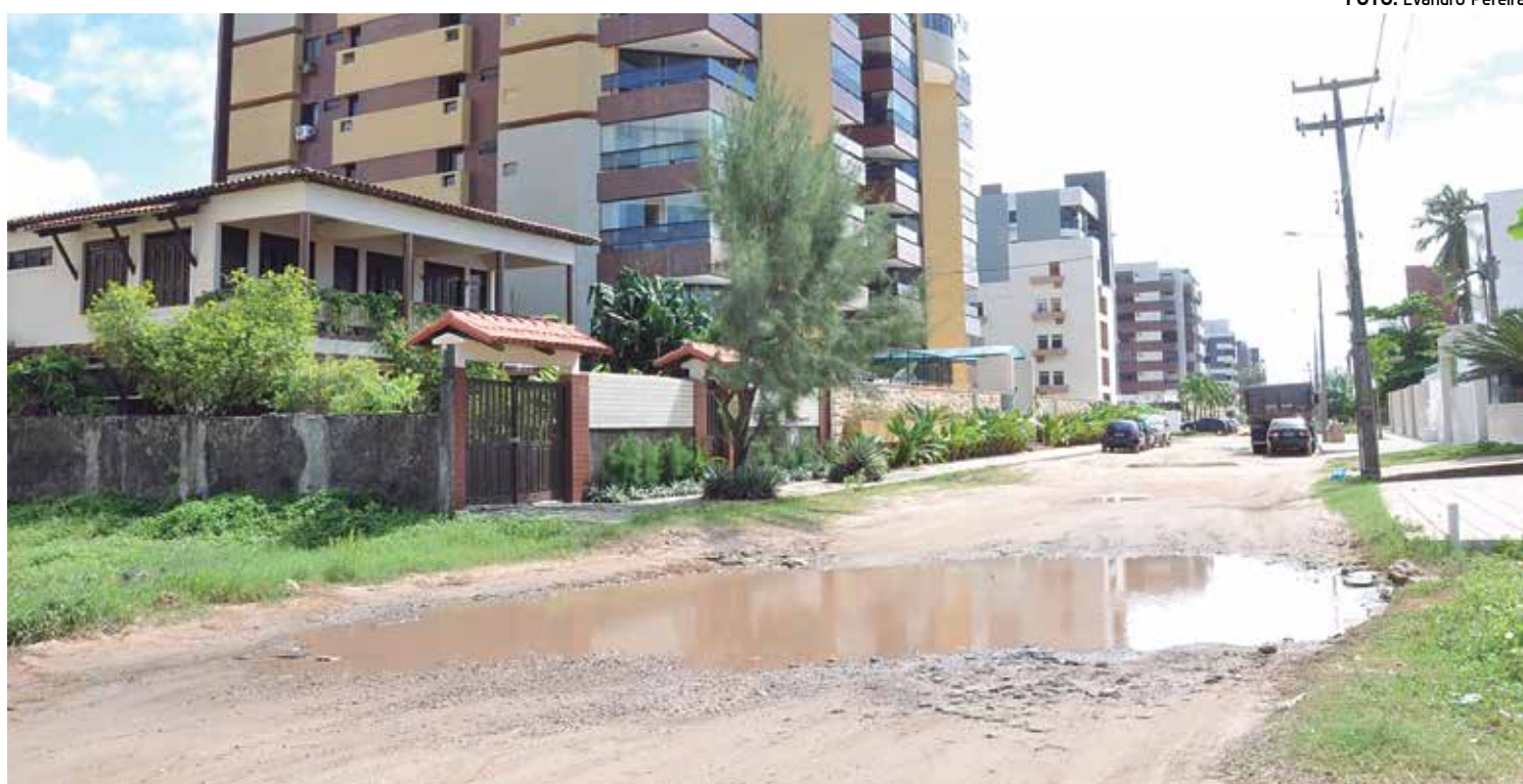
O TCE concluiu que José Francisco Régis excedeu gastos em obras de melhoria e pavimentação no sistema viário no bairro de Intermars
